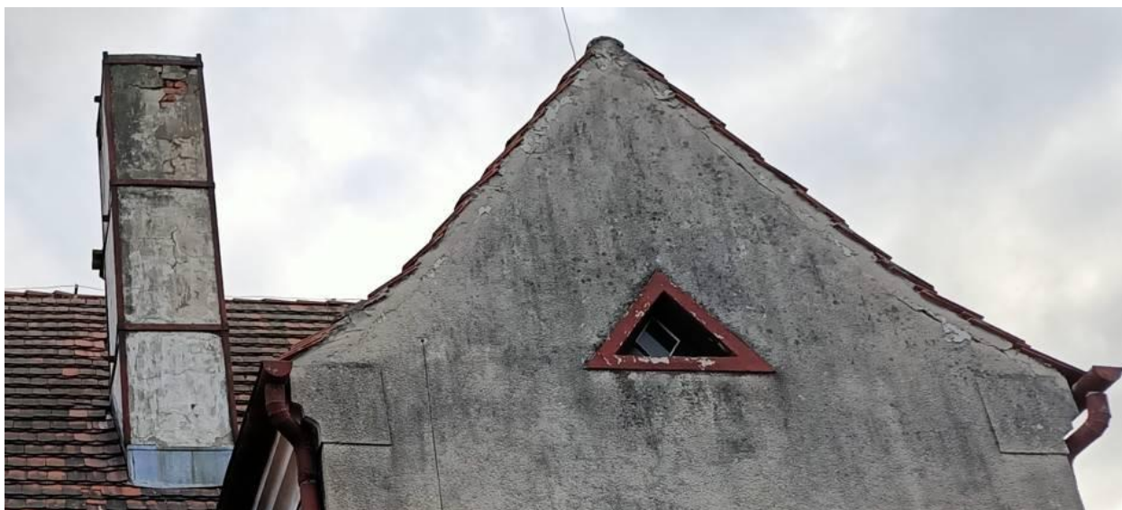
Uszkodzenia komina , tynków ścian szczytowych.
