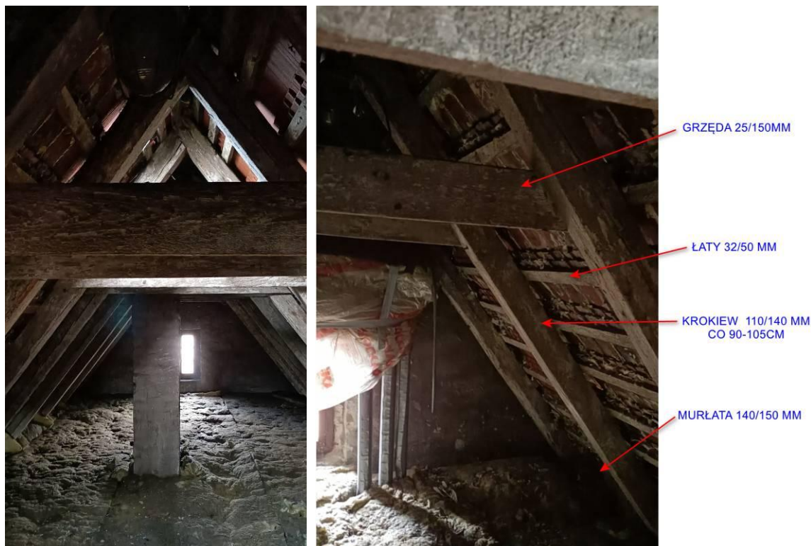
Fot. 6,7 Widok konstrukcji więźby dachowej, poddasze nieużytkowe nad II piętrem.
