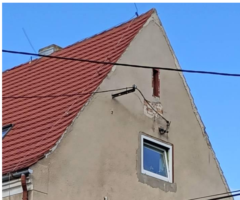
Uszkodzenia tynków
